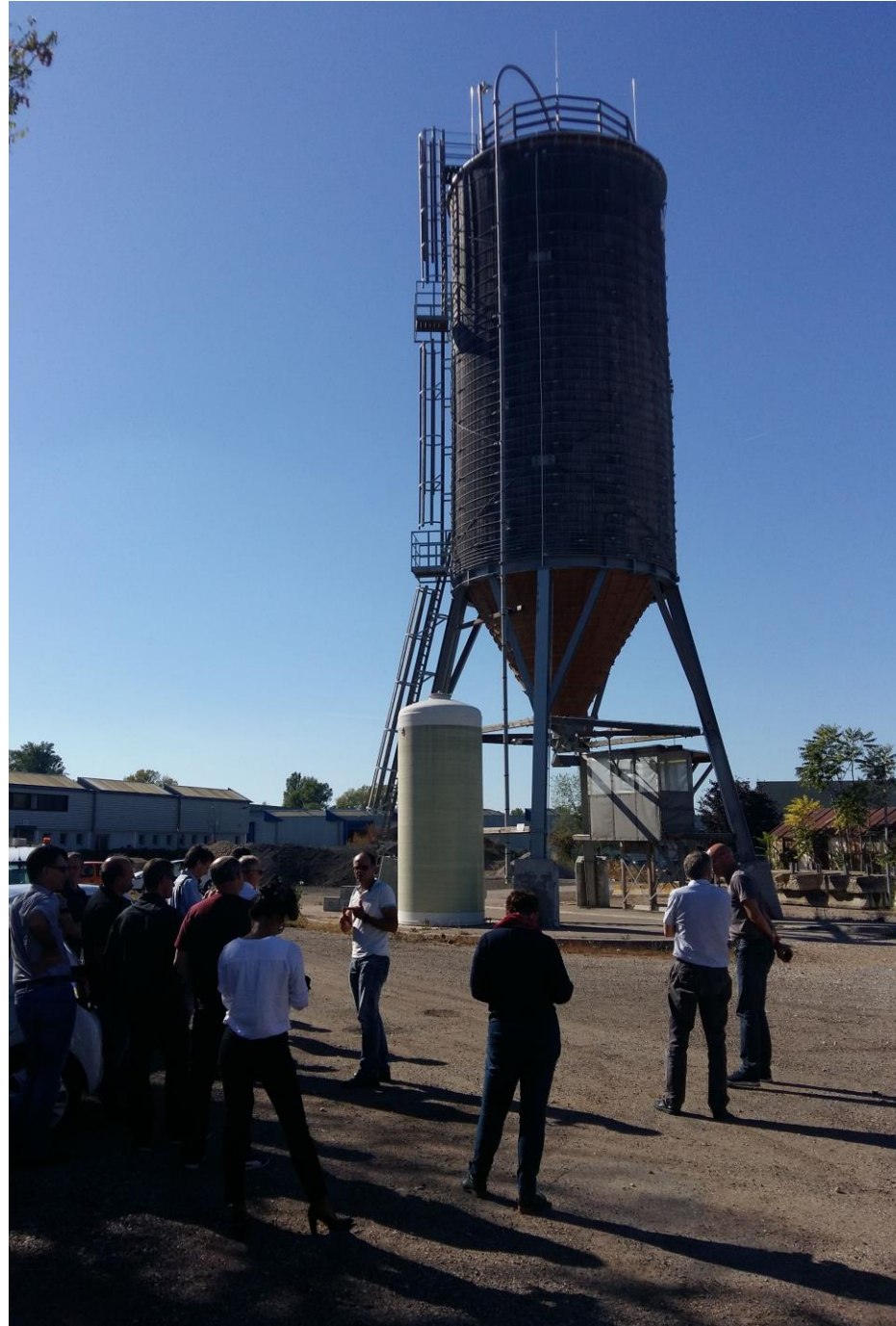
Silo installé au département de l'Isère au centre de Crémieu.
