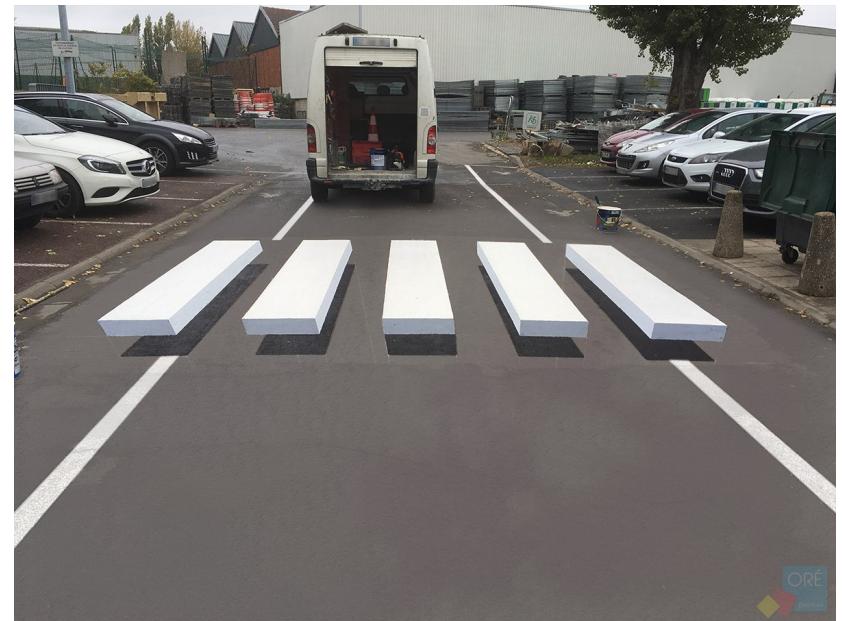
Marquage réalisé en peinture
